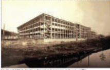
En 1953, le lycée Arago, le bâtiment principal et l'édifice principal en 1953.
