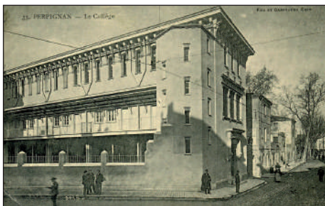
Le collège Arago dont une grande partie a été démolie
