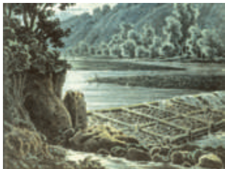
Les " rescloses " sont des barrages destinés à dévier l'eau vers un canal d'irrigation tout en maintenant un débit au cours d'eau principal (les dessins sont de F. Jaubert de Passa)
